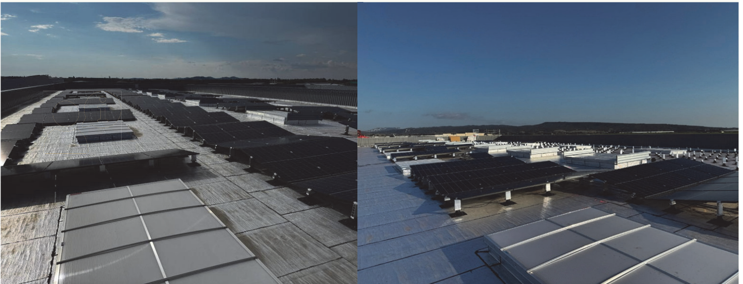
Toiture de l'agence de Tarascon.
